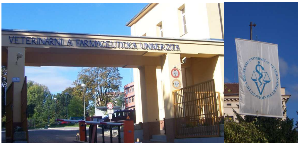
Uniwersytet w Brnie mieści się w jednym, rozbudowanym kampusie.
